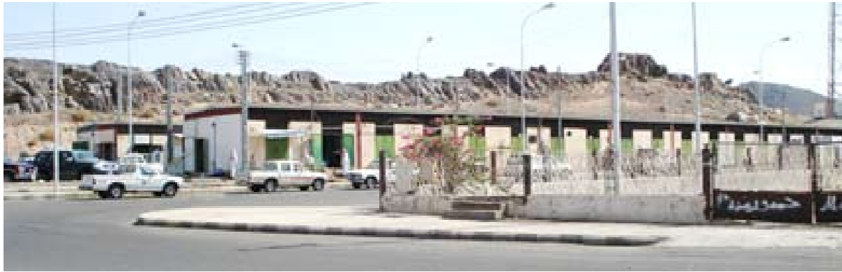
صورة توضح مدخل السوق والطريق المؤدي إليه.
